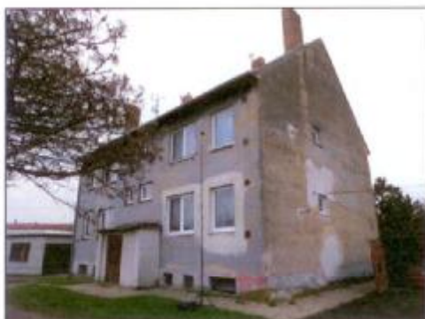
Obrázek č. 2 – pohled na měřicí místo A
