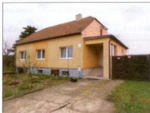
Obrázek č. 3 – pohled na měřicí místo B
