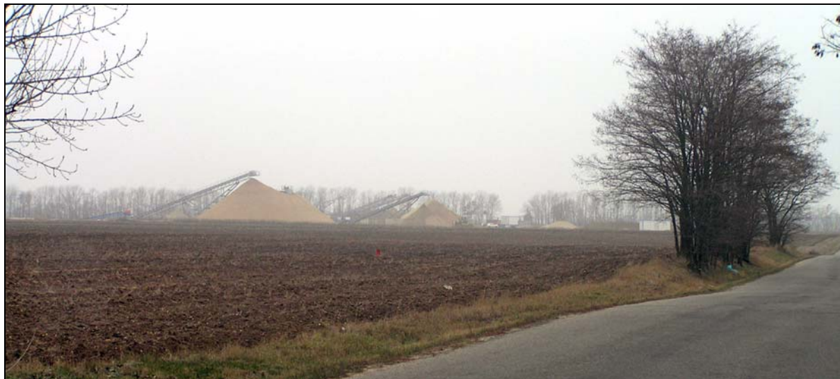
Obrázek č. 7: Pohled na úpravnu od východu ze silnice č. III/39523
