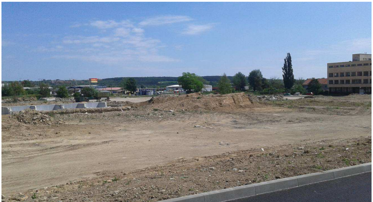
Obr. č. 6: Zemní práce a zakládání stavby, budou v důsledku složitého terénu a zbytků základů v bývalém průmyslovém areálu, vyžadovat poměrně náročné práce - i při nich musí být důsledně dbáno na ochranu ŽP (prašnost, případný výskyt NO)
