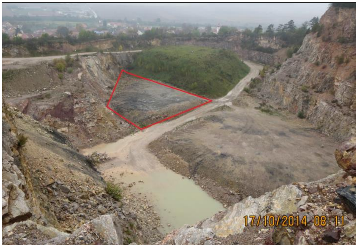
Foto č. 1: Prostor budoucího zařízení (bez vegetace)
