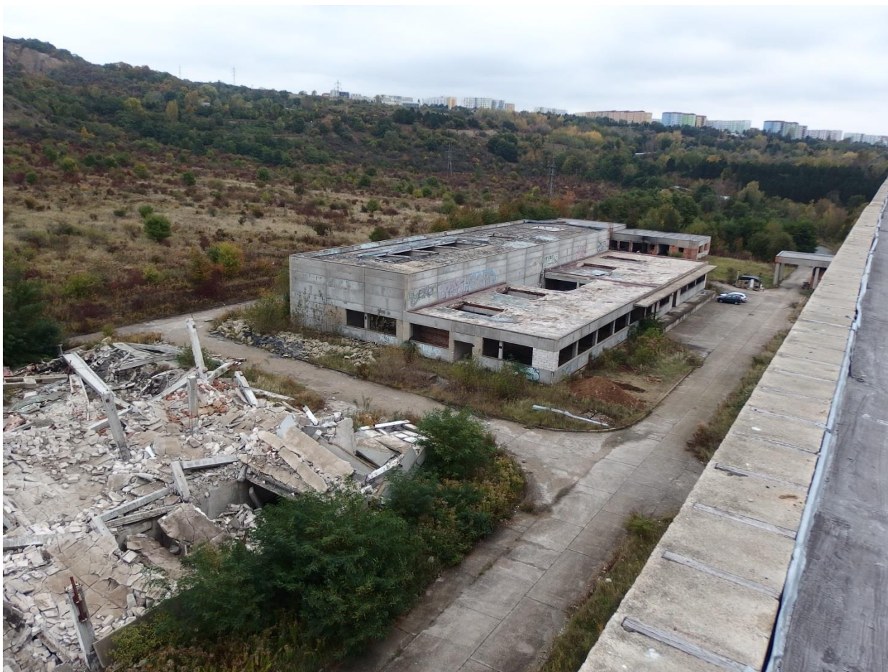
Obr. 12 V popředí stavební suť po demolici haly, za ní nedostavěný objekt továrny Ergon a v pozadí vrátnice u vstupu do areálu s obslužnou komunikací.
