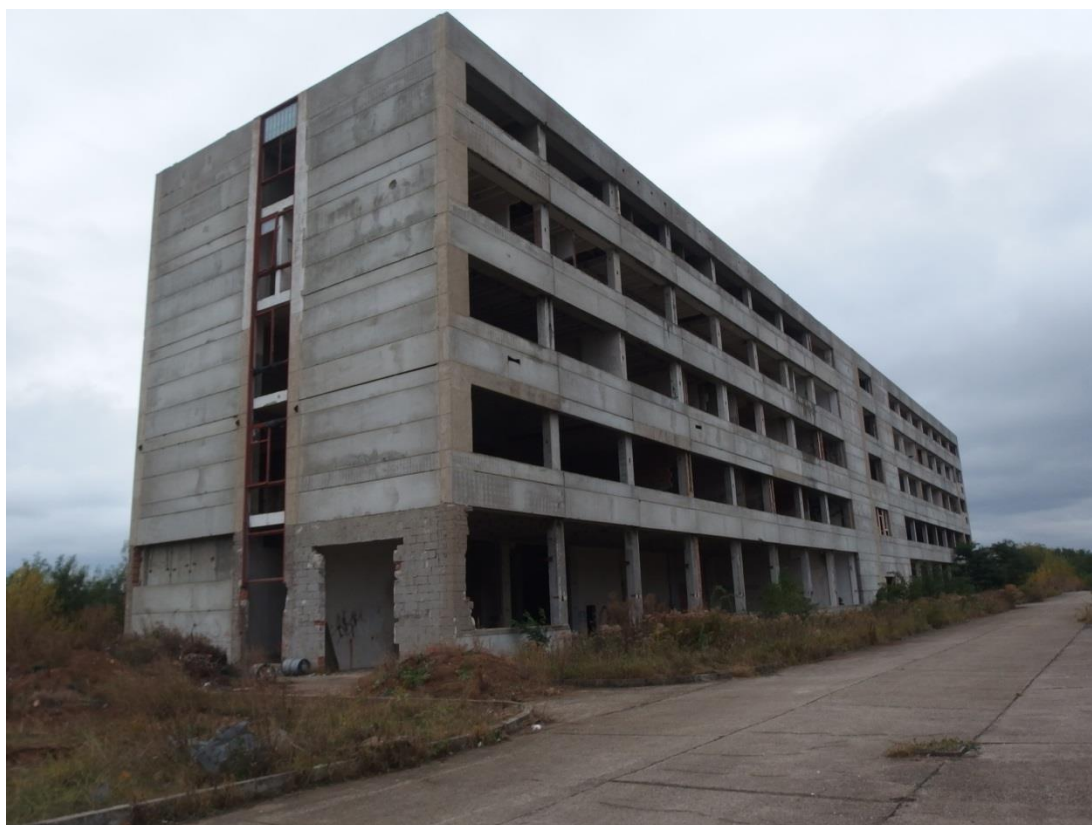
Obr. 13 Torzo hlavní budovy nedostavěného výrobního areálu Ergon.
