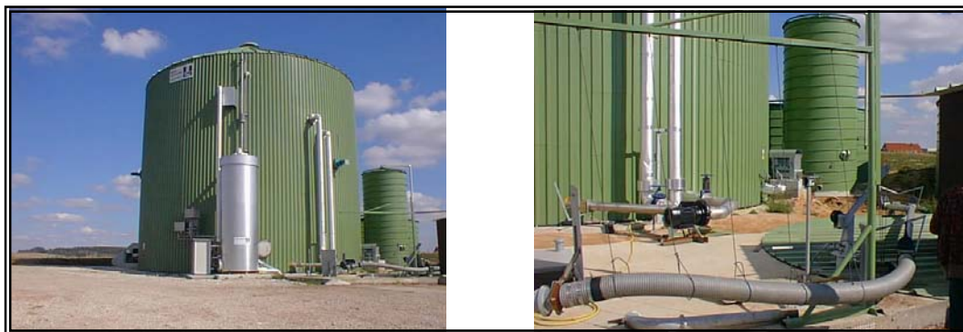
Bioreaktor s odsiřovací jednotkou a čerpáním bioplynu
