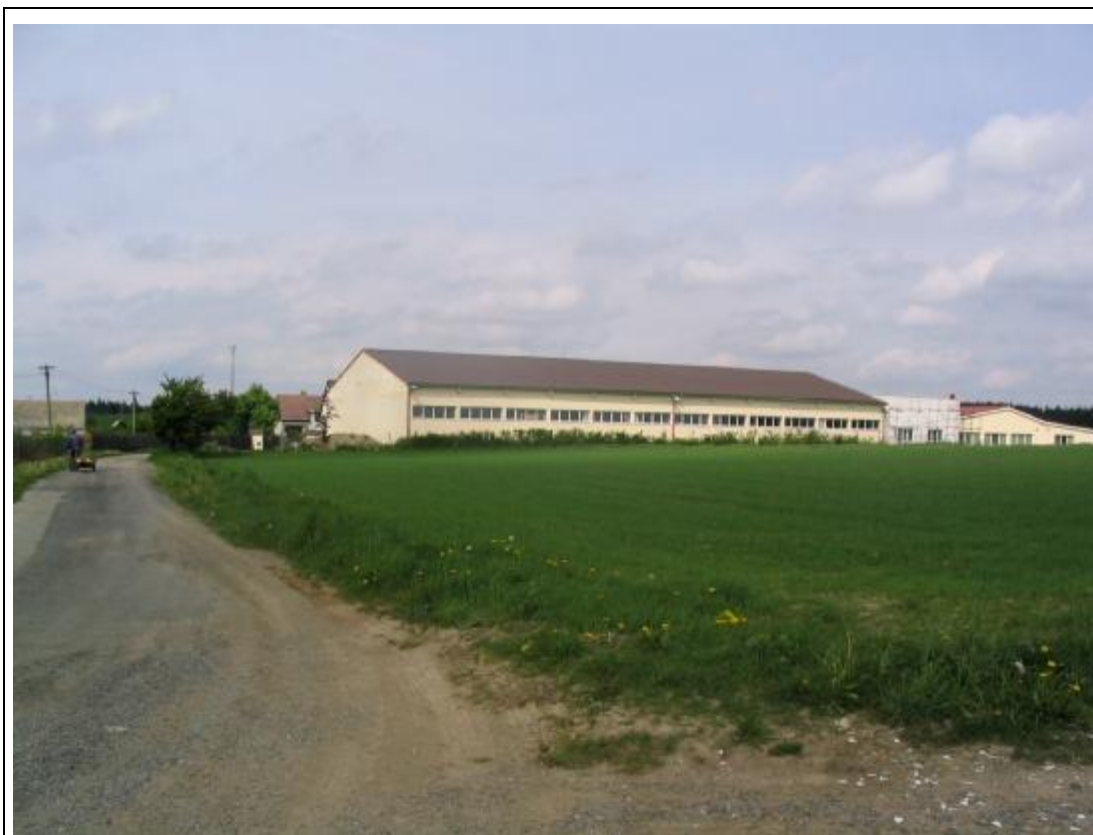
Areál od JZ s příjezdovou komunikací pro nákladní vozidla, část prostoru před halou je určena k realizaci záměru
