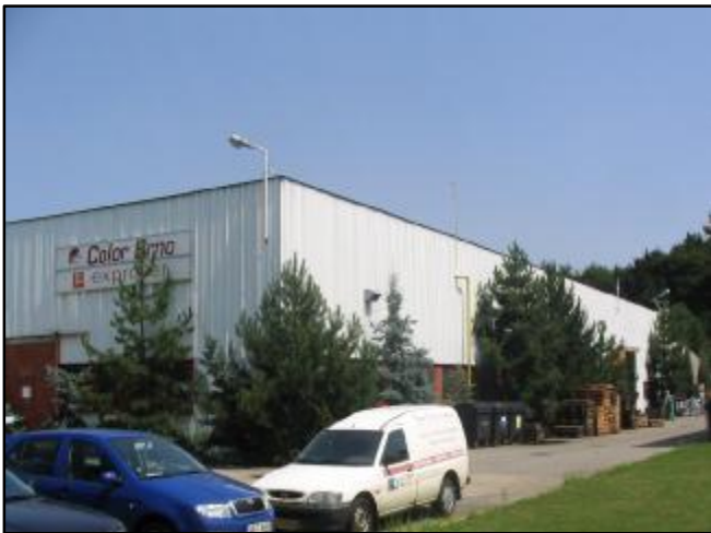
3. Hala č. 1 – sv. pohled
