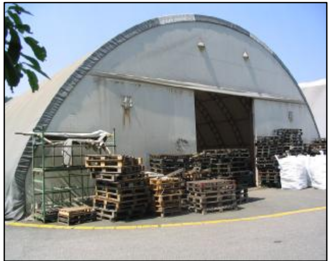
2. Hala č. 4 – vstup, jižní pohled
