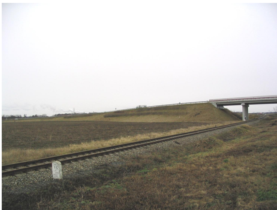
Obr. 4: Současná podoba území záměru, pohled od silnice k tělesu nájezdu R 52 Brno - Mikulov
