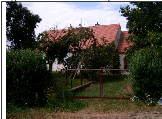
Výp. bod č. 7 – Budova RD, jižní strana
