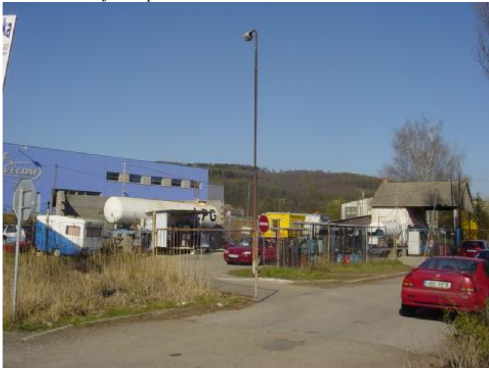
Pohled na stávající čerpací stanici LPG
