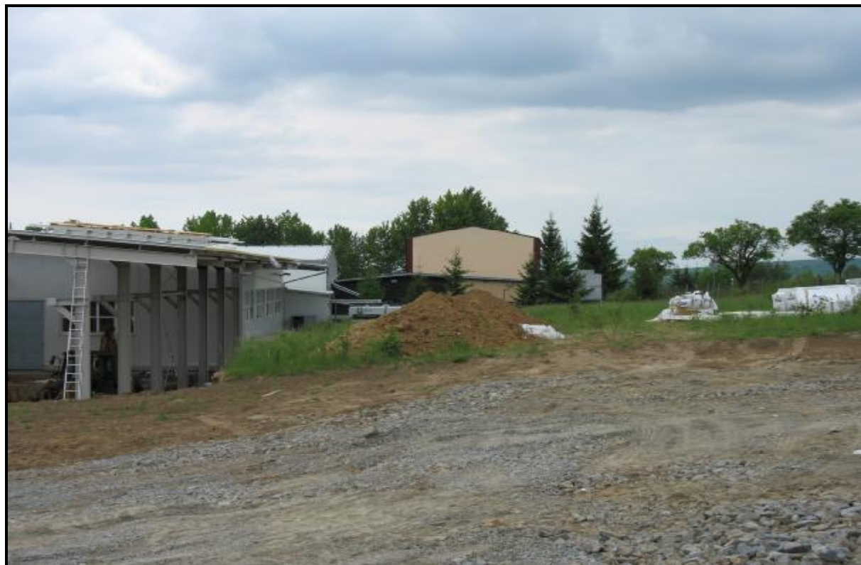
Obr. 2 Plocha určená k výstavbě skladu hotových výrobků
