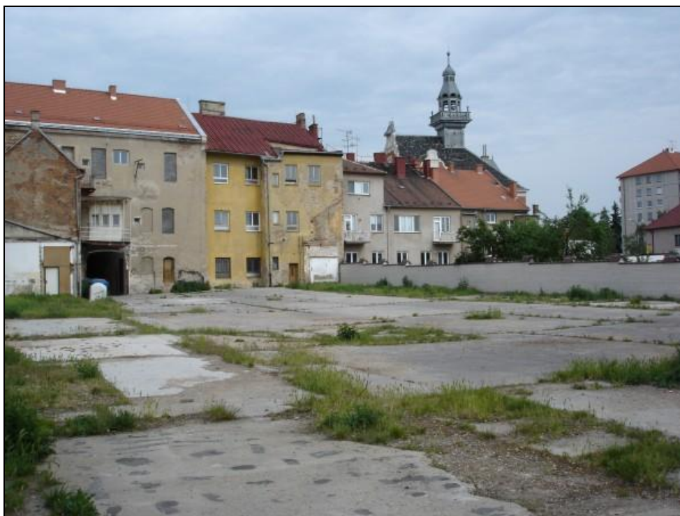
Obr.3 Pohled na dvorní trakt domů Masarykovo nám. 5 a 6
