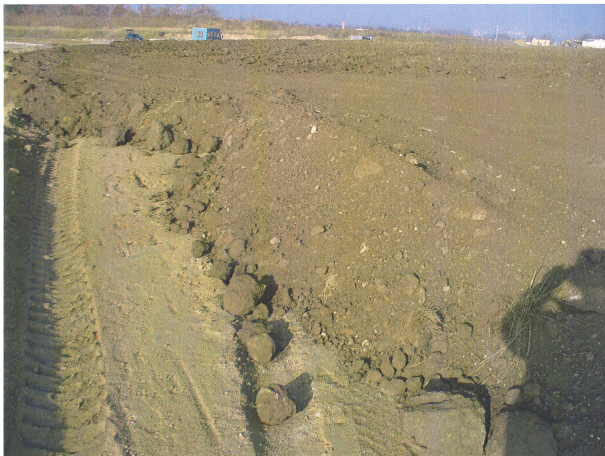
2 Postup technické rekultivace - vrstvení podorničních a ornických horizontů
