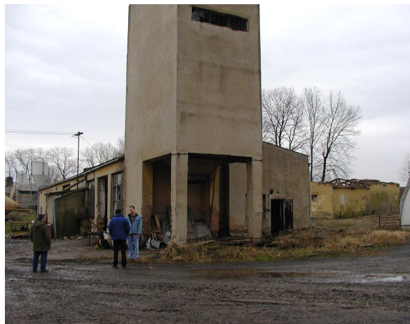
Pohled na původní kotelnu která bude přestavěna na provozní budovu
