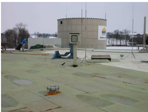
Pohled na strop fermentoru (v pozadí plynojem)
