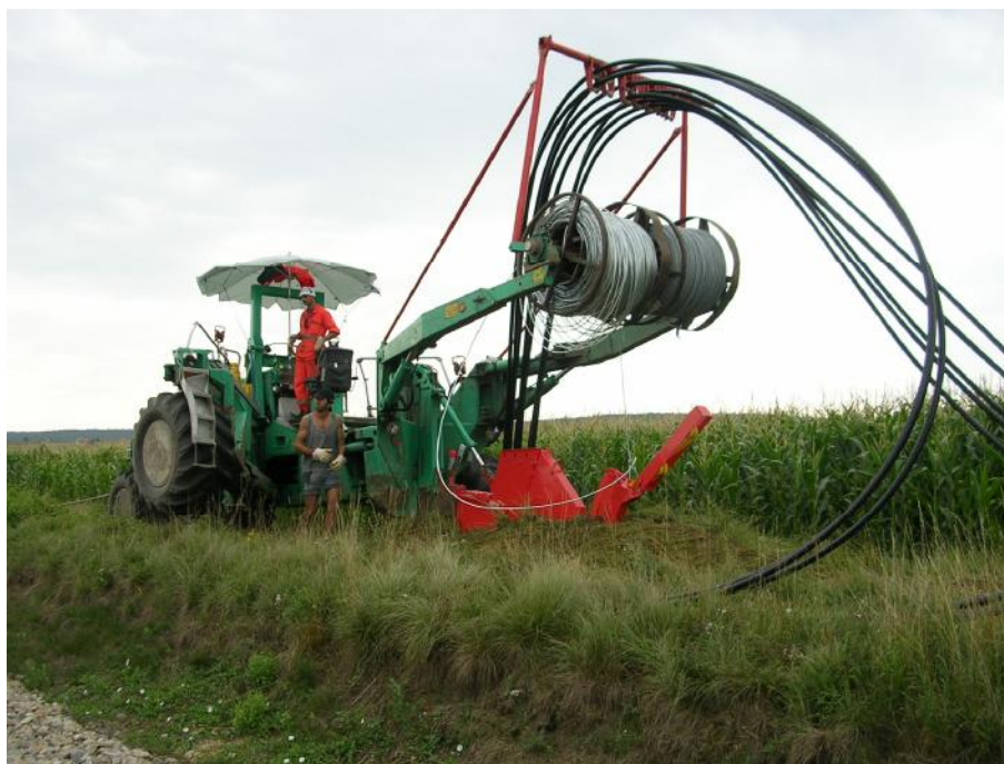
Obr.: Technika pro pokládku kabelu
