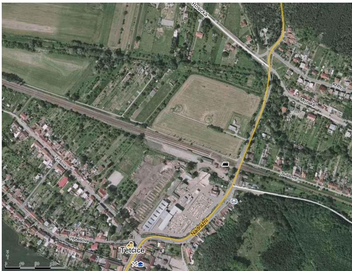
Obr. D.I.8/1: Letecký pohled na zájmový prostor a okolí
