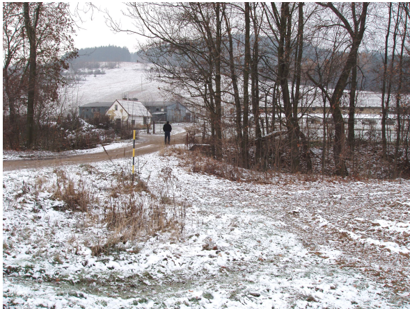
Foto č. 4 : Stávající mostek přes potok
