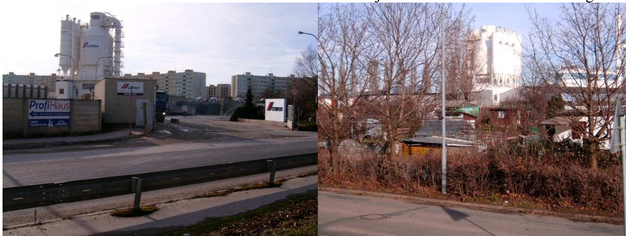
Obr. č. 9. Pohled na areál CEMEX - betonárna Brno od vjezdu a na areál od ulice Schwaigrova
