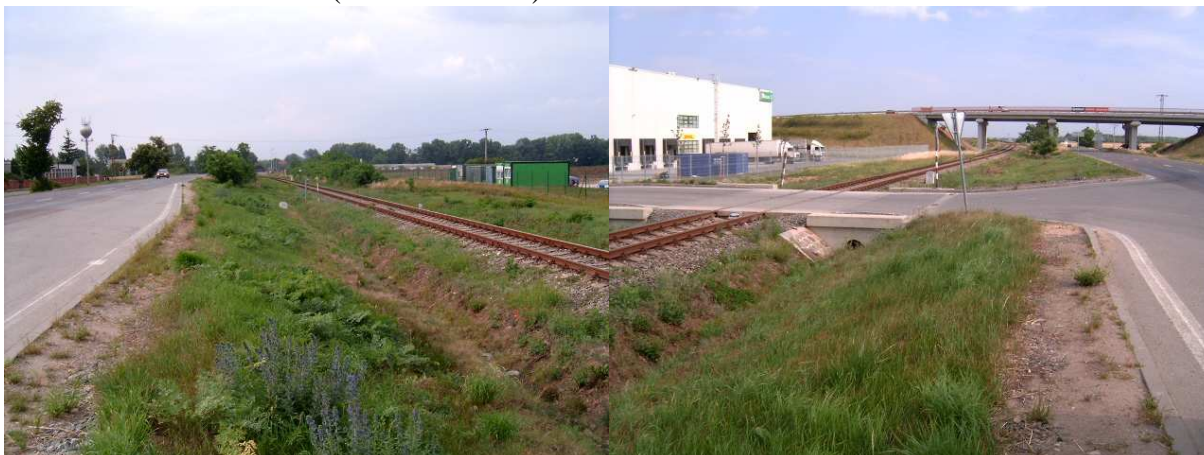
Obr. č. 16. Silnice II/395 (ulice Vídeňská) a MÚK silnice R 52
