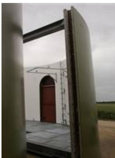
Obr. 10 – Základový díl betonového tubusu VE a nosná konstrukce pojezdu montážní plošiny
