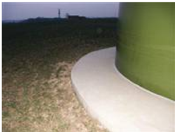
Obr. 9 – Detail základu VE a montážní plošina při výstavbě betonového tubusu VE
