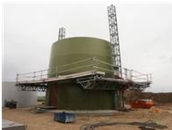
Obr. 9 – Detail základu VE a montážní plošina při výstavbě betonového tubusu VE
