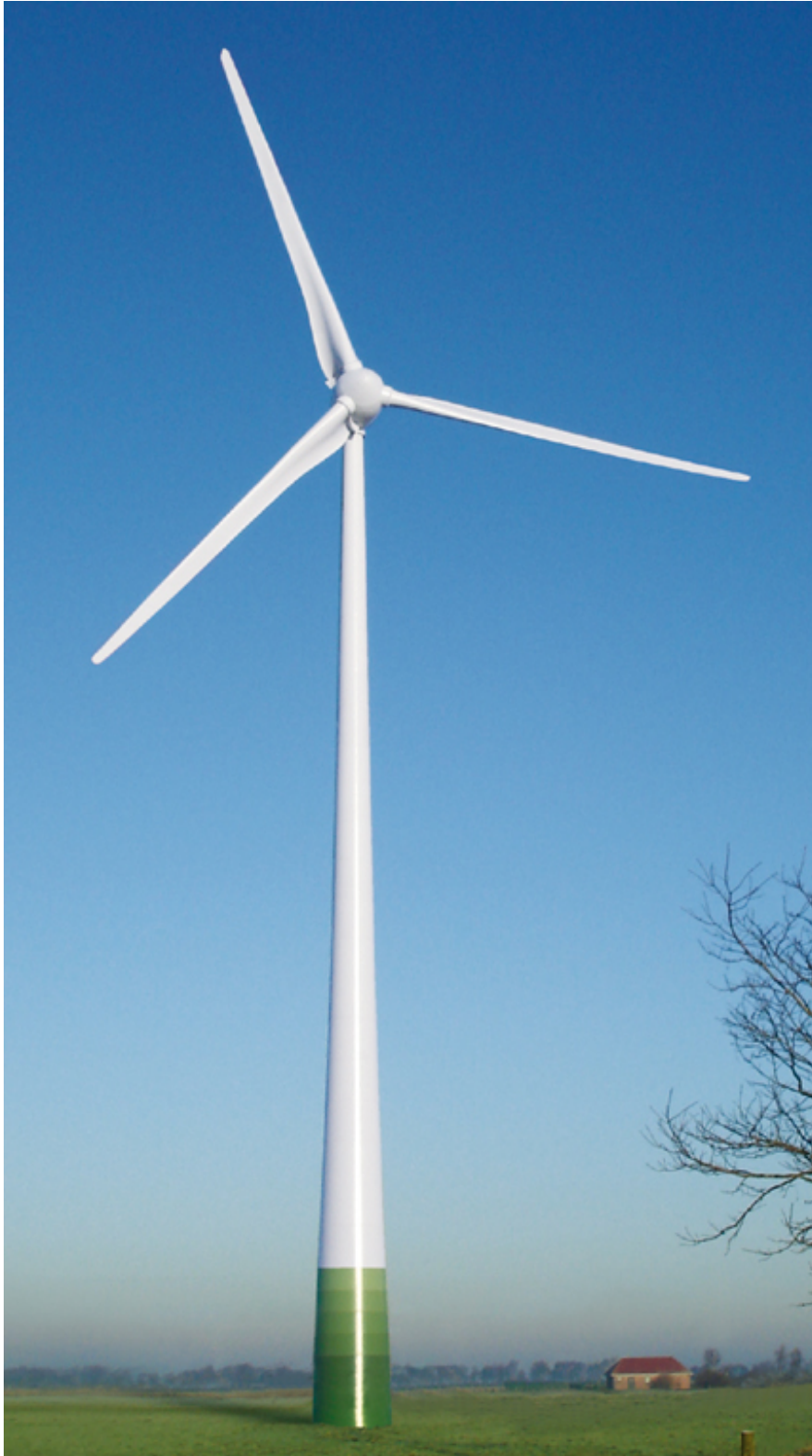
Obr. 7 – Větrná elektrárna ENERCON E-82
