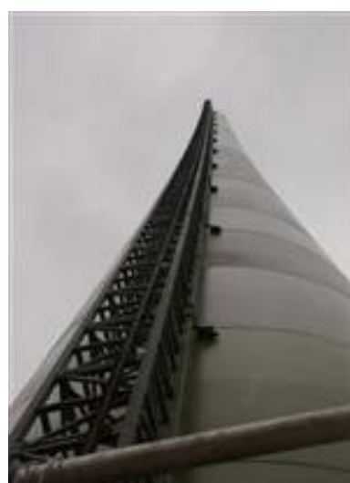
Obr. 10 – Základový díl betonového tubusu VE a nosná konstrukce pojezdu montážní plošiny
