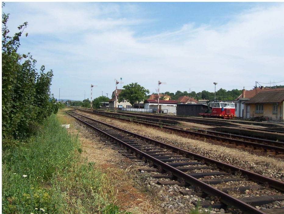
Obr. 1: Žst. Nesovice – současný stav před rekonstrukcí
