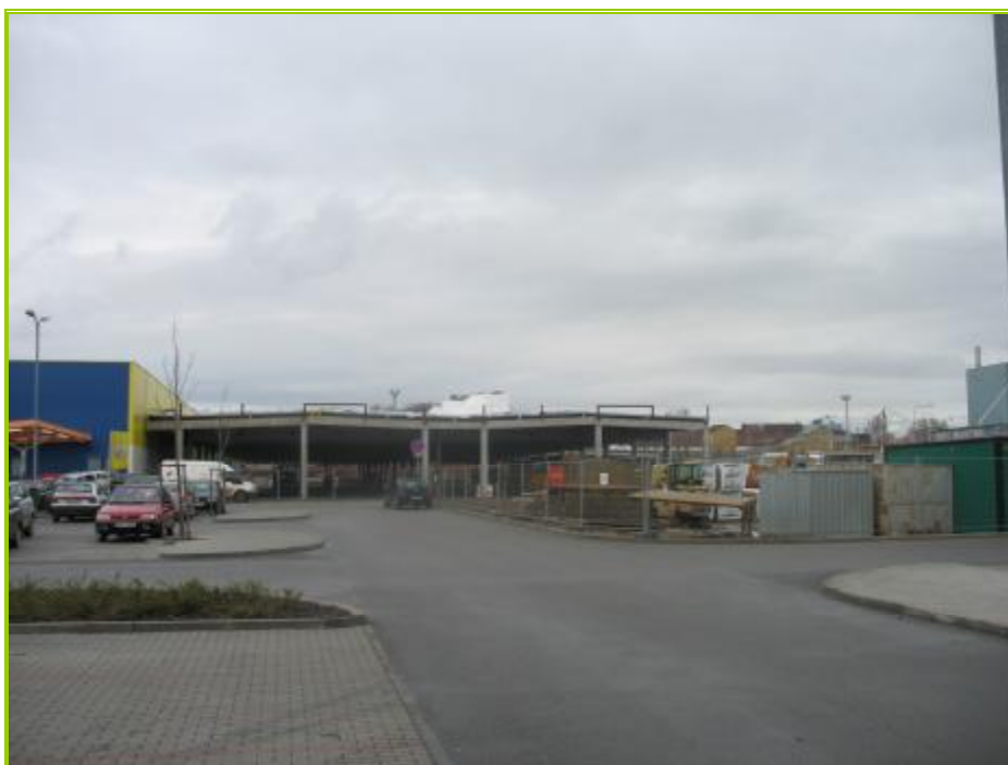
Obr.3 Pohled rozestavěný objekt OC Crystal
