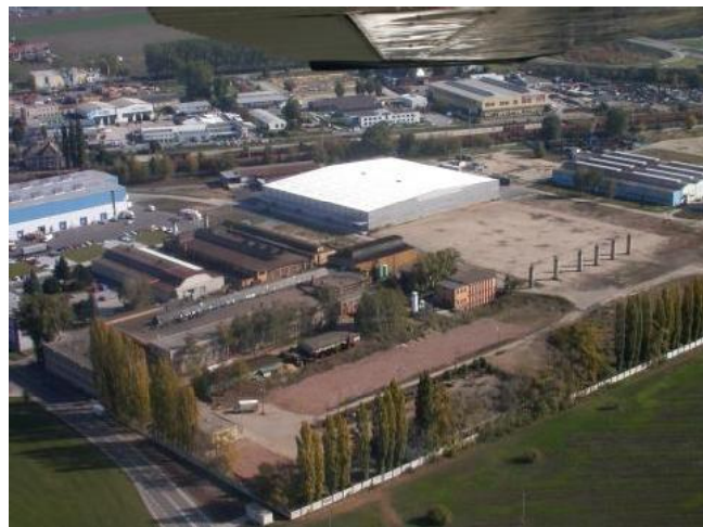
Celkový pohled na areál z JZ
