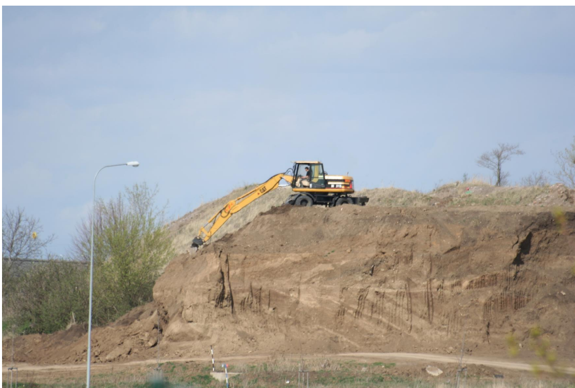
Obr. 8: Terénní práce na SZ části Švédských valů na jaře 2008.
