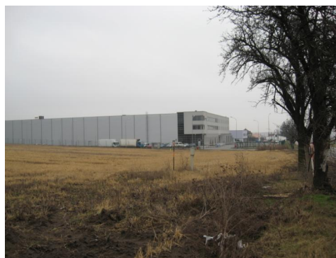
Pohled na východ - objekt firmy Movianto
