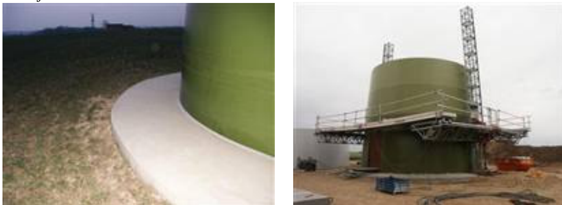
Obr. 4 – Detail základu VE a montážní plošina při výstavbě betonového tubusu VE
