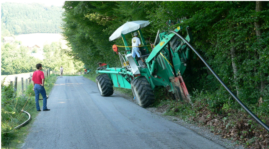
Obr. 4 – Bezvýkopové kladení kabelové přípojky
