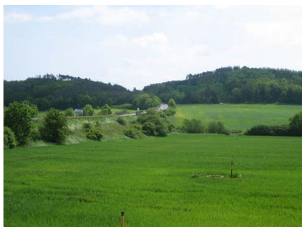
pohled na začátek obchvatu
