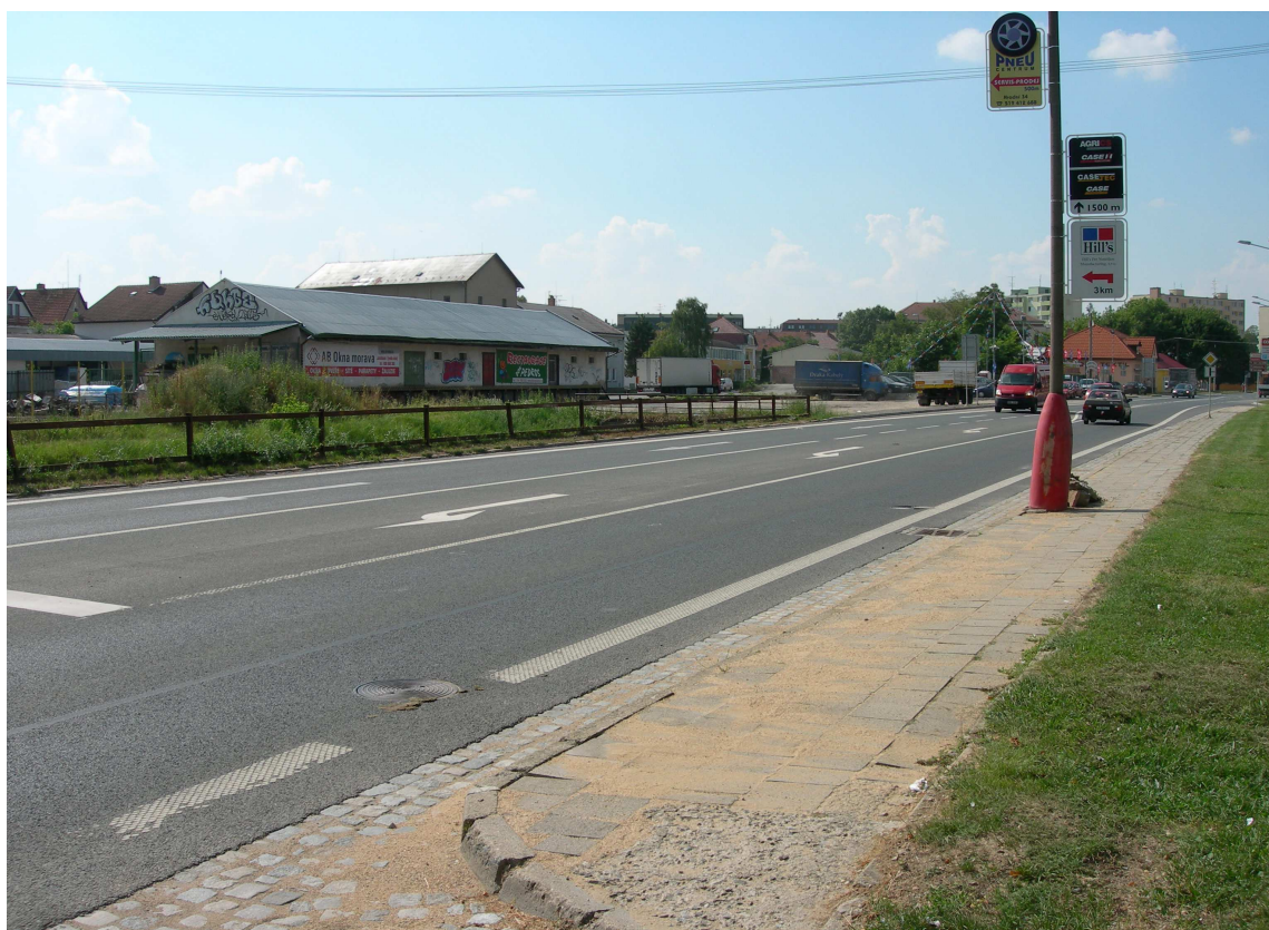
Obr. 1 a 2: Ulice Bratislavská s komunikací č. II/425 (Židlochovice-Hustopeče-Břeclav) a chodníkem pro pěší, bude tvořit hlavní „spojnici“ města s budoucím obchodním centrem.
