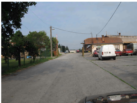
Stávající vjezd do areálu ZD
