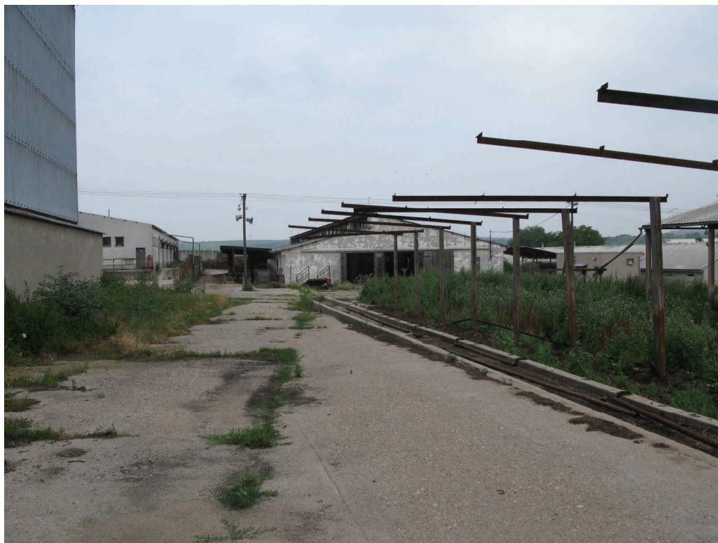
OBRÁZEK 6: POHLED NA BUDOUCÍ PROSTOR ZÁMĚRU
