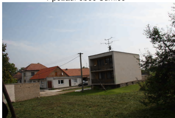
č.p. 25 a č.p 92 v obci Šumice
