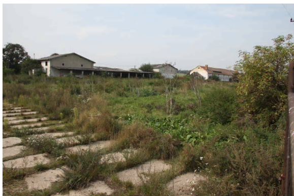
Stájové objekty uvnitř areálu
