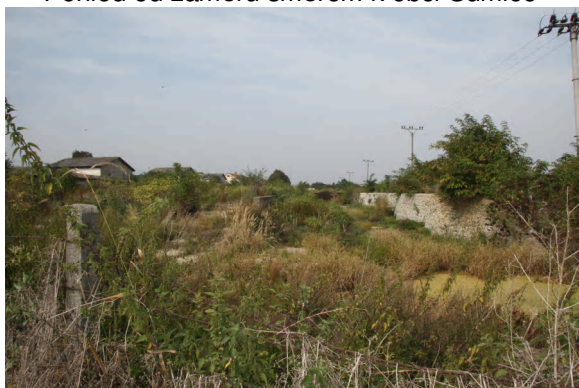
Plocha záměru s rozpadlými silážními žlaby
