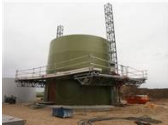
Obr. 3 – Detail základu VE a montážní plošina při výstavbě betonového tubusu VE
