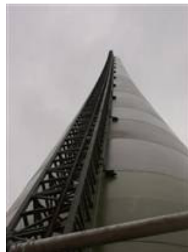
Obr. 4 – Základový díl betonového tubusu VE a nosná konstrukce pojezdu montážní plošiny
