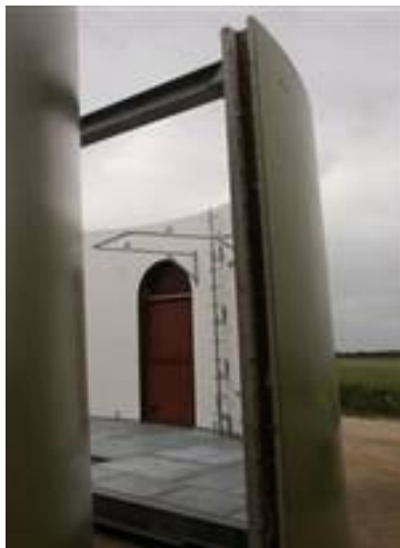
Obr. 4 – Základový díl betonového tubusu VE a nosná konstrukce pojezdu montážní plošiny
