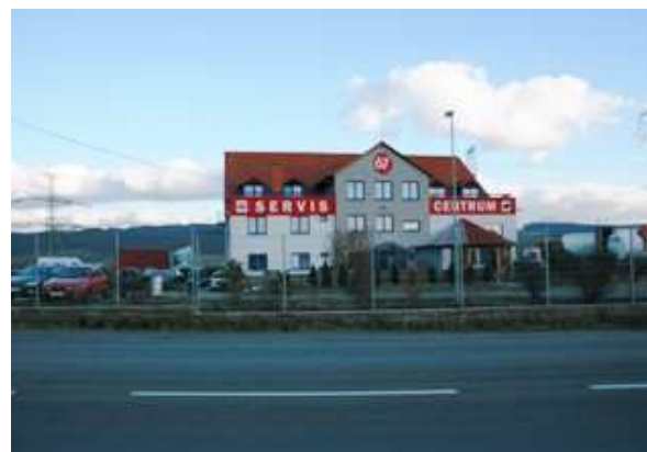
Foto č. 6: Pohled od silnice na zástavbu v blízkosti budoucí výstavby
