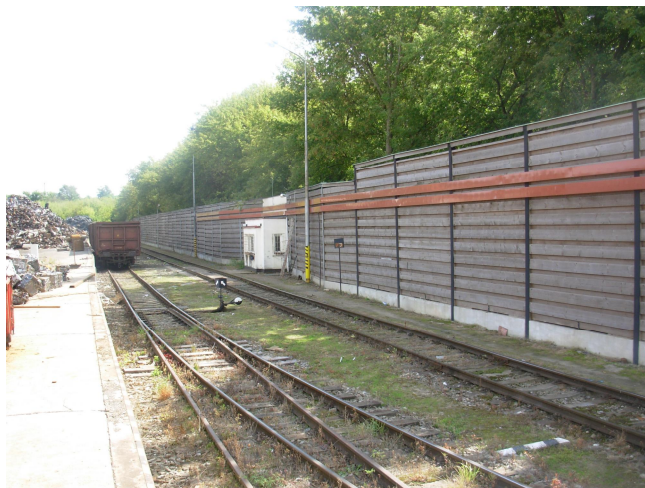
Obr.: Protihluková stěna
