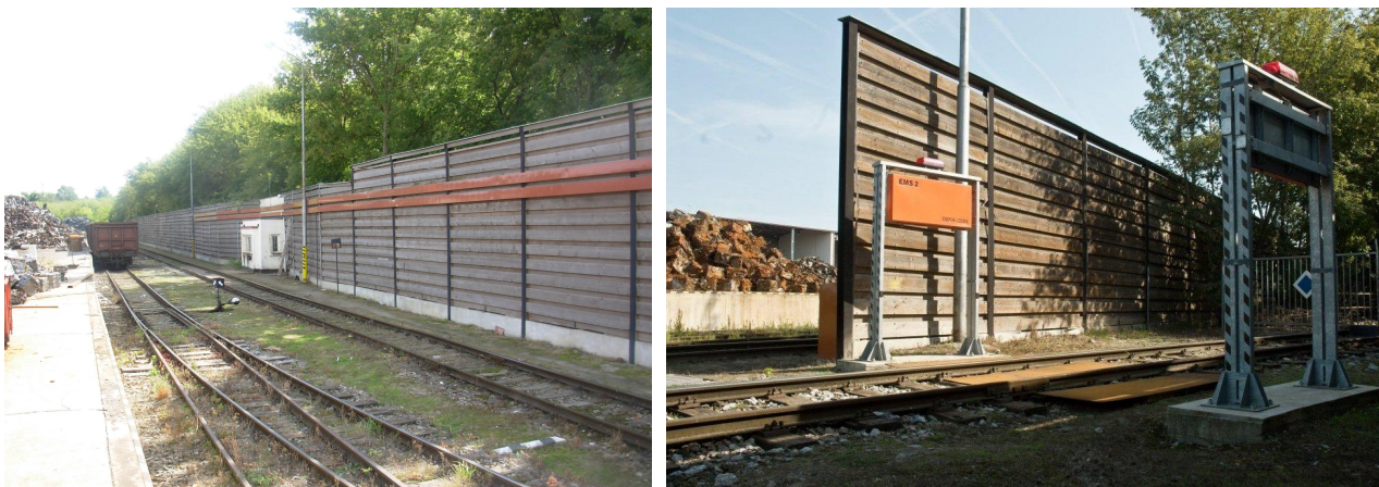
Obr.: Stávající protihluková stěna
