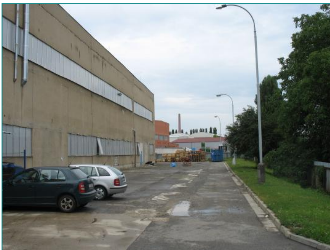
Obr.2 : Pohled na plochu budoucího staveniště objektu SO 01 Přístavba budovy
