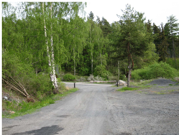
účelová komunikace k výjezdu z areálu kamenolomu
