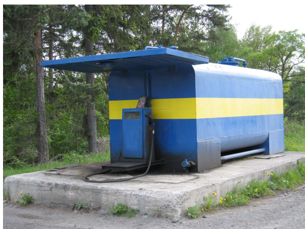
čerpací stanice nafty
