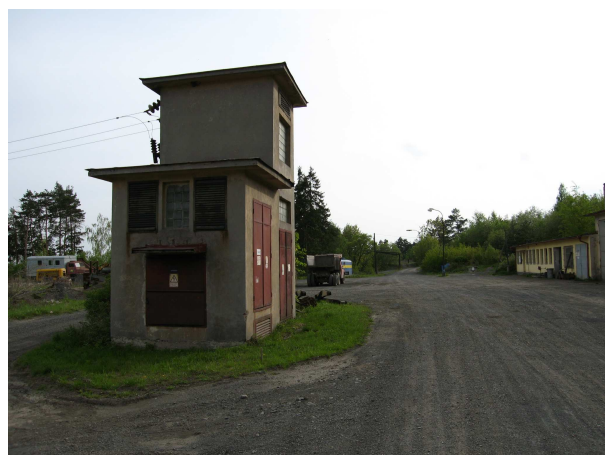
stávající trafostanice - bude přemístěna
