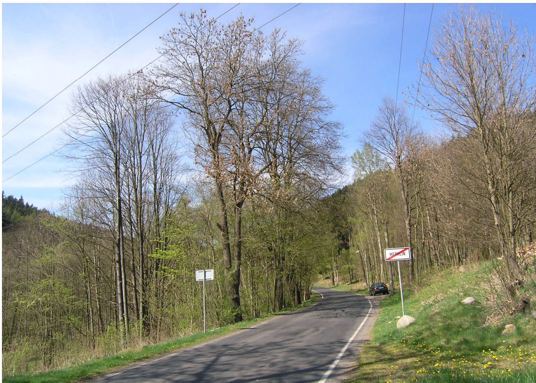
Foto 1: Pohled na počátek rekonstruovaného úseku silnice II/221 (km 0,000) na okraji sídelního útvaru Merklín. V náletovém porostu po levé straně komunikace se zachovaly hodnotné exempláře lip původního alejového doprovodu komunikace, tyto stromy je nezbytné v průběhu stavby ochránit před poškozením a úpravu komunikace doplnit v tomto úseku svodidlem.
