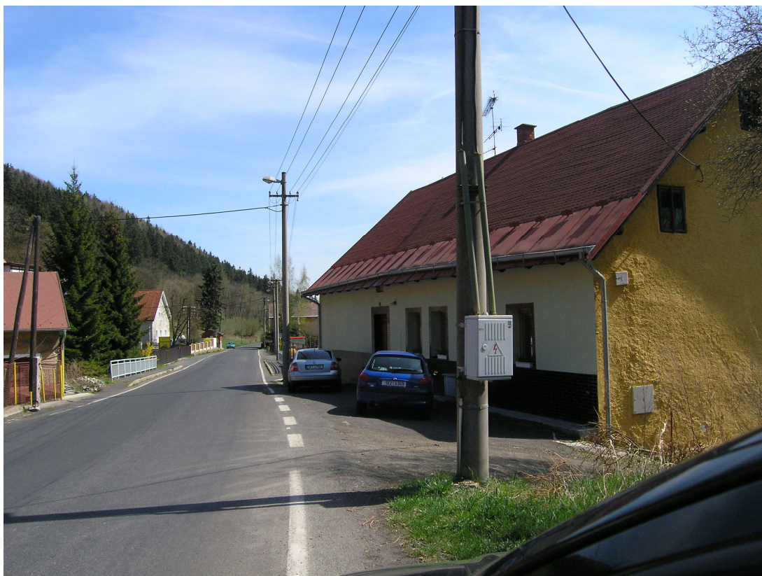
Foto 11: V místech, kde silnice prochází obytnou zástavbou bude řešena v intravilánovém uspřádání s rychlostí omezenou na 50km/h.
