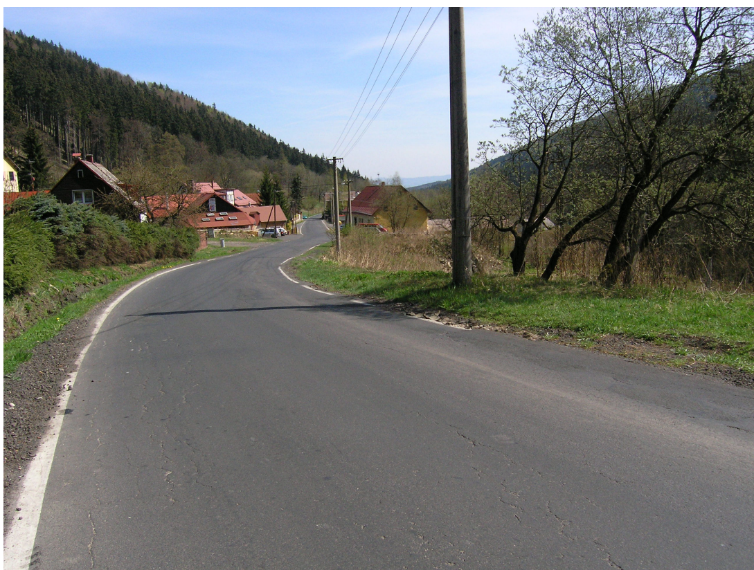
Foto 12: Pohled na konec rekonstruovaného úseku na okraji sídelního útvaru Pstruží – km 3,328, kde se napojuje na již rekonstruovaný úsek směrem k Perninku.
