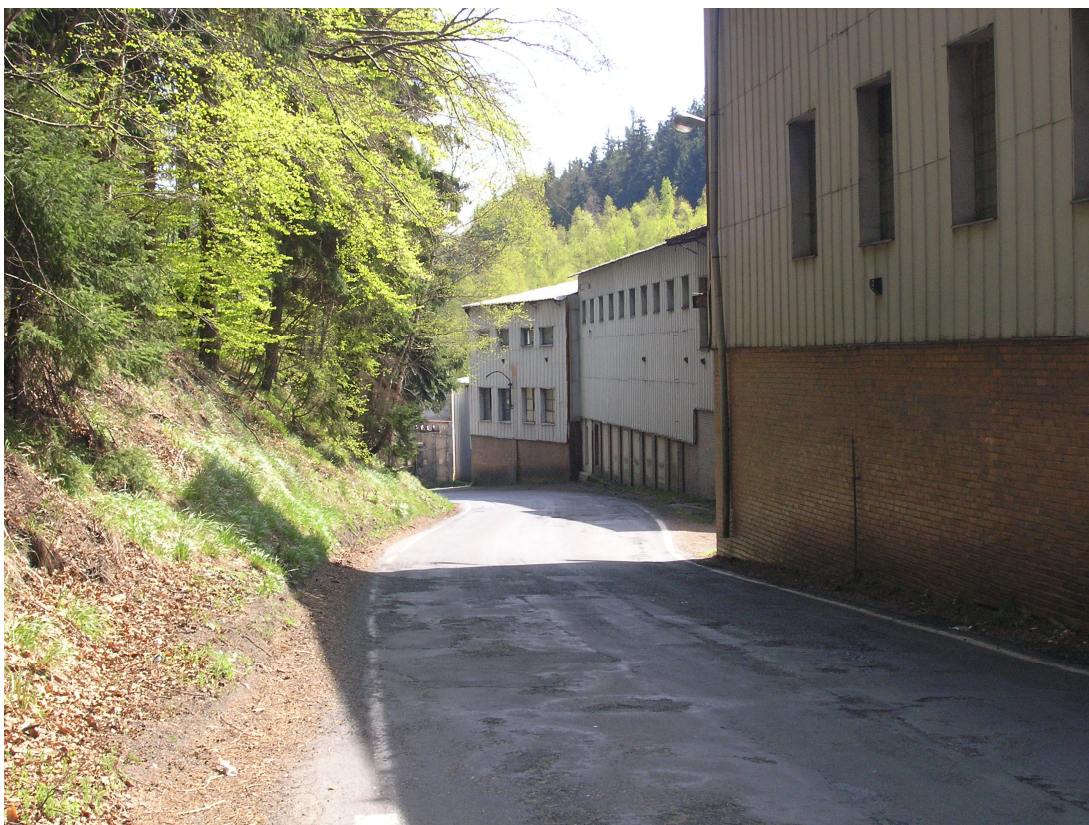
Foto 3: Úseky komunikace s nepřehlednými zatáčkami budou v rámci rekonstrukce napříměny. V úseku u papírny (km 0,480 – 0,530) nutné zhotovit poměrně rozsáhlý zářez do paty svahu s masivní opěrnou zdí. Tato konstrukce si vyžádá zásah do kontaktního lesního porostu.
