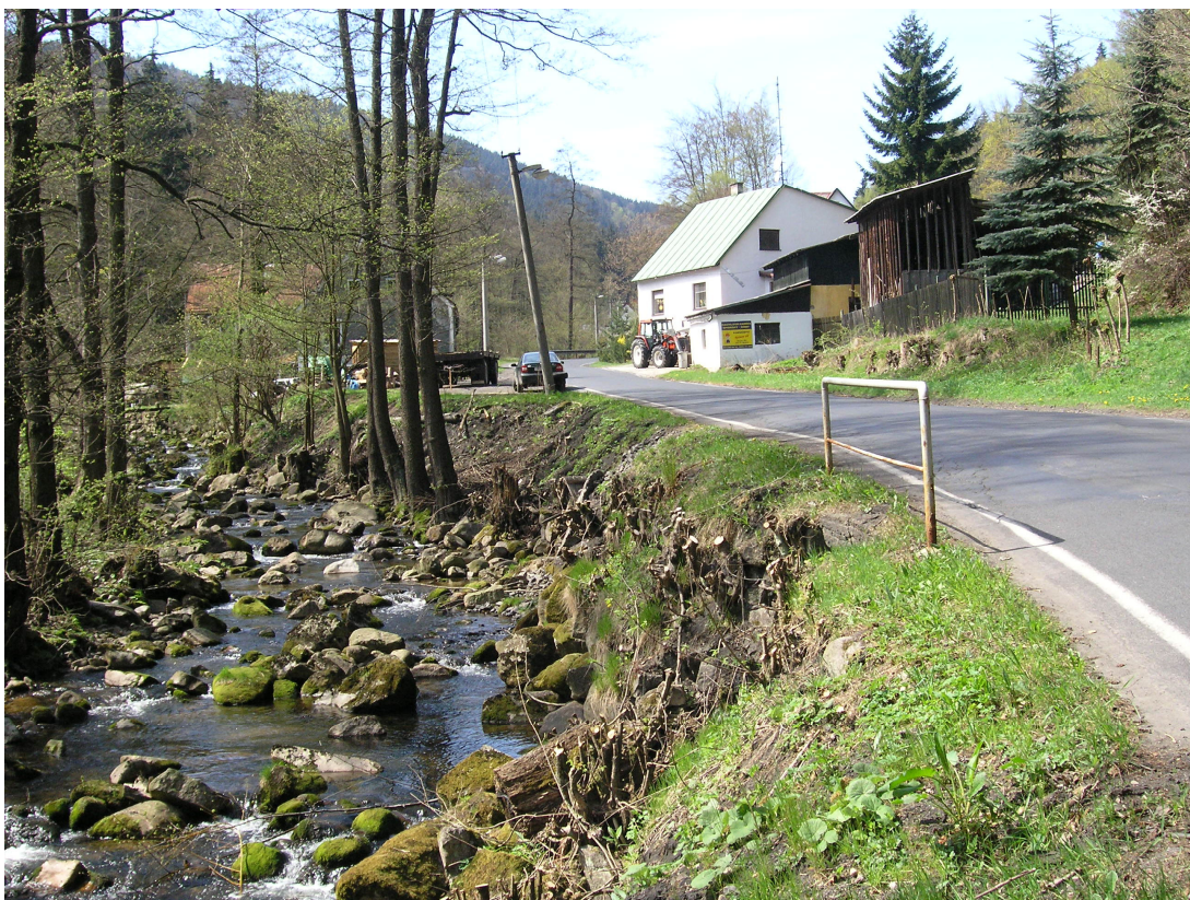
Foto 5: V místech, kde se koryto horské bystřiny – Bystřice přimyká k tělesu komunikace budou vybudovány opěrné zdi. V těchto místech budou též odstraněni dřeviny v manipulačním pásu širokém cca 1,5 m na obě strany od opěrné zdi. Situace v km 1,100.
