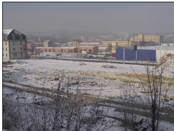
Foto č. XVII (1.2.10): pohled od objektu 3 - PH KOVO-RECYCLING CHEB s.r.o. přes budoucí staveniště na Pražskou ulici, vlevo objekt 6a - kanceláře, vpravo 2 - TESCO , pohled od V
