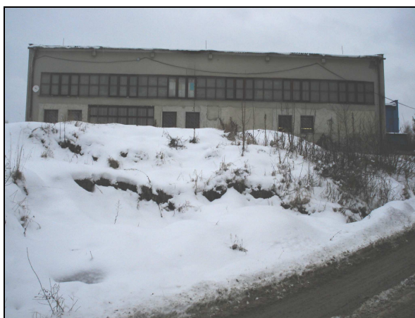
Foto č.IV (2.2.10): Objekt 5a – Maan , který je vzdálen od jižní stěny navrhované budovy OC Pražská cca 37 m , pohled ze S, z Karlovy ul.
