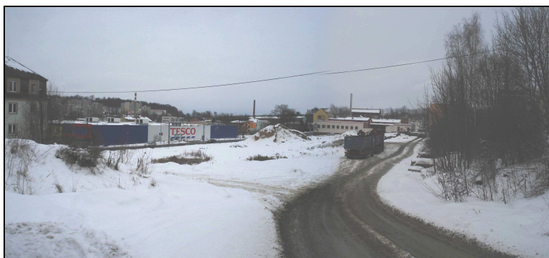
Foto č.I-III (2.2.10): 2 – OD TESCO vzdálen od S stěny navrhované budovy cca 55 m – pohled z JZ; vlevo patrný objekt 6d , uprostřed za nákladním autem odvázejícím výkopek je objekt 6b (bývalý masokombinát), v popředí TESCA Pražská ulice; vpravo místní křoviny a dřeviny
