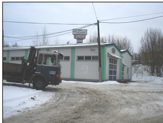
Foto č. VI (2.2.10): Objekt 5c – Fr. Kopún, kovoobrábění , který je vzdálen od J stěny navrhované budovy OC Pražská více než 50 m , pohled ze Z, z Karlovy ulice
