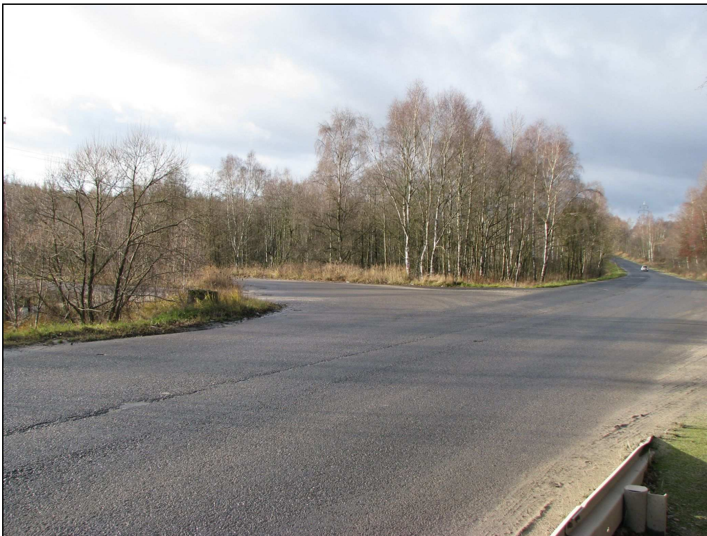
Foto č. 6: Silnice III/2222 Dolní Nivy – Vřesová, vlevo odbočka ke skládce SATER-CHODOV a k budoucímu zpracovatelskému závodu komunálních odpadů.
