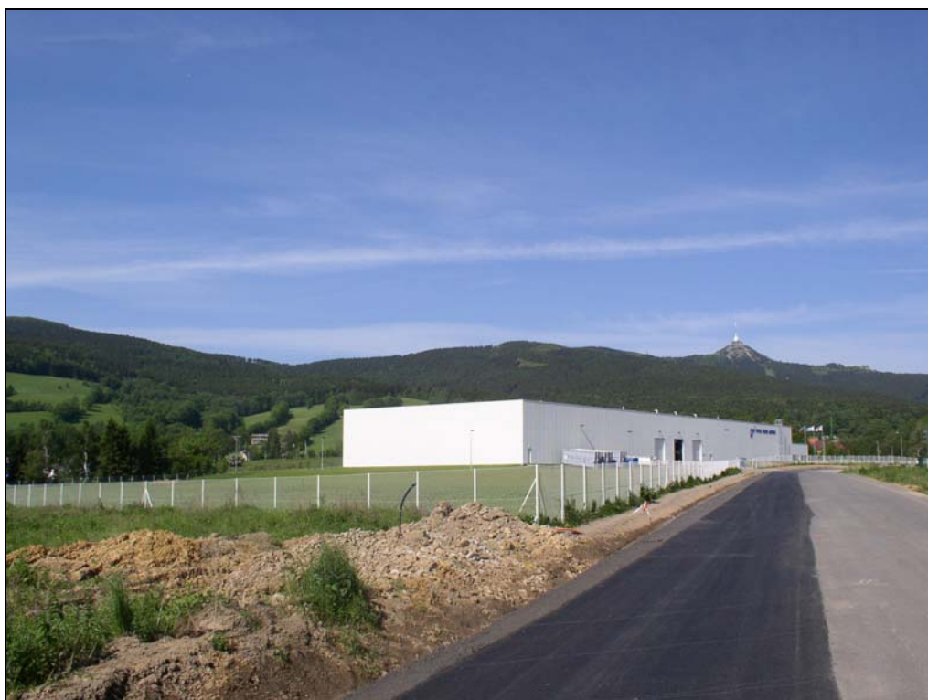
obrázek 4 – stávající hala I.
