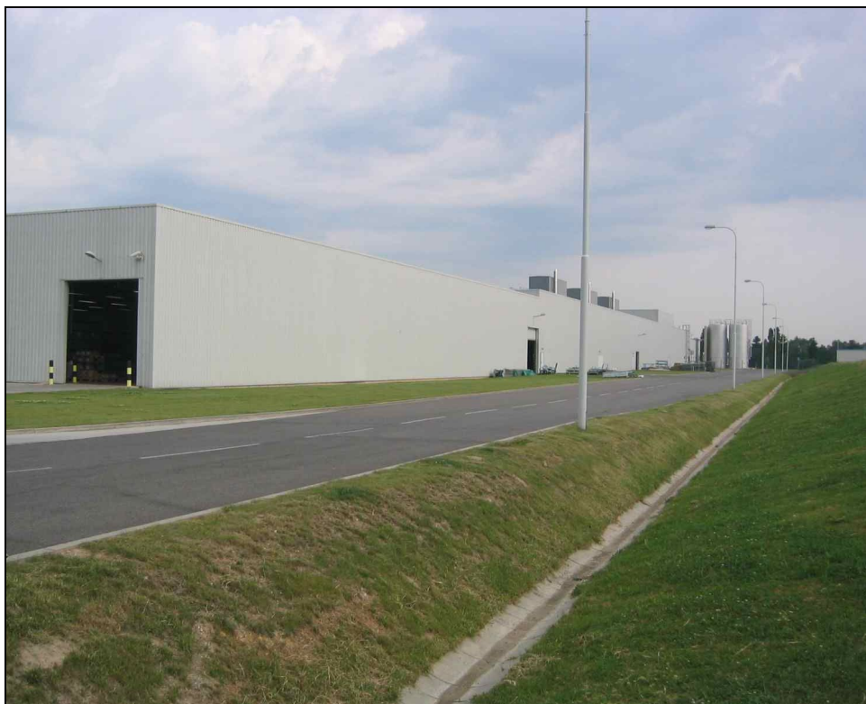
Obrázek 3: Stěna výrobní haly, kam bude manipulační hala přistavěna
