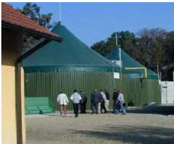
Obrázek 3: Fermentory s integrovanými plynojemy (Rakousko)
