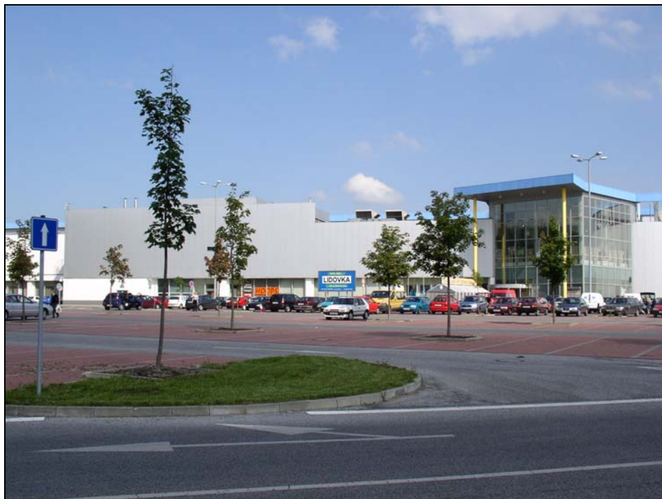
Obrázek č.4 : Jižní část areálu – plocha pro stavbu dvoupodlažní parkoviště Jih
