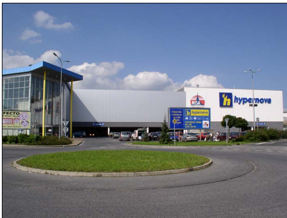
Obrázek č.3 : Východ areálu – dostavba parkovacího objektu
