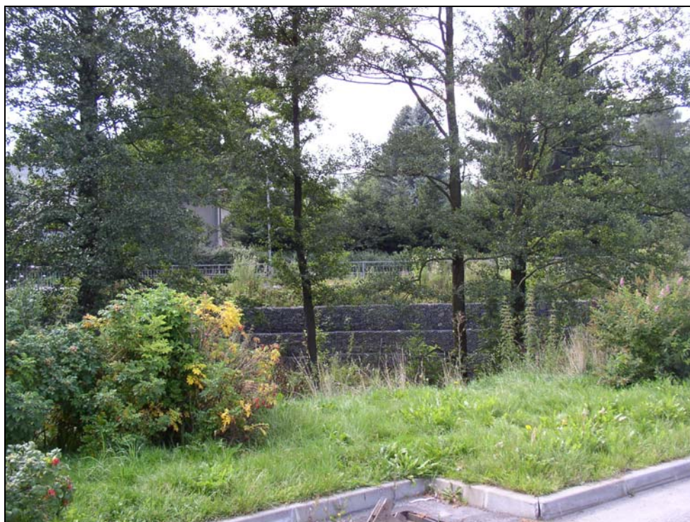
Obrázek č.5 : Pravý břeh Plátenického potoka u parkoviště Jih- zpevněný gambiony
