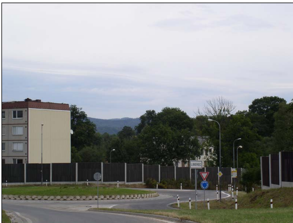
Obrázek 6: Protihluková stěna u kruhového objezdu (pohled z odbočky ze silnice I/35)
