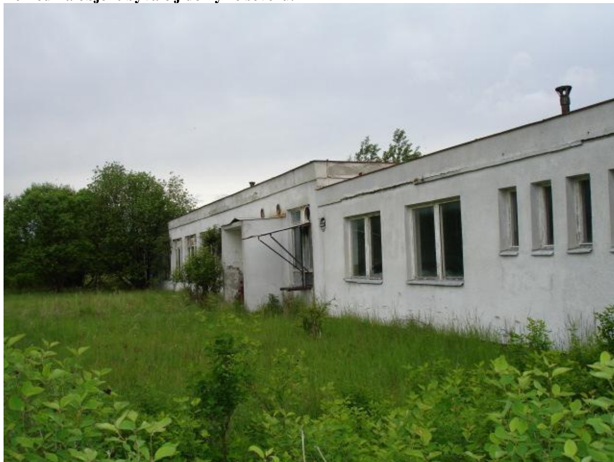
Pohled na objekt bývalé jídelny ze severu.
