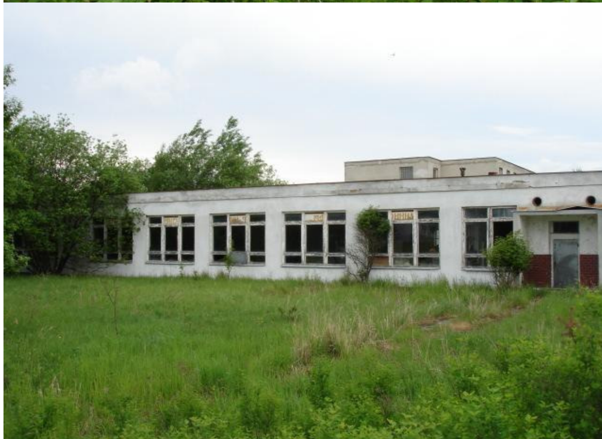
Pohled na objekt z jižní strany.
