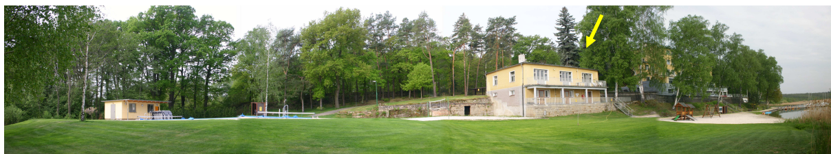
Obr.17. Pohled na místo dostavby hotelového křídla, hotel je za břízami
