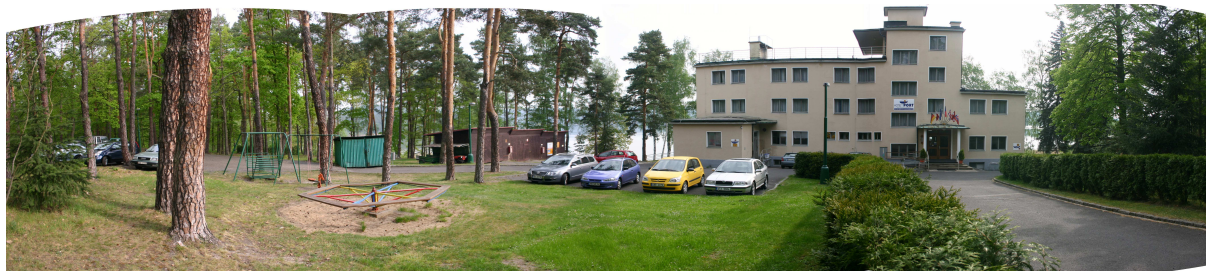
Obr.21. Pohled na hotel od západu
