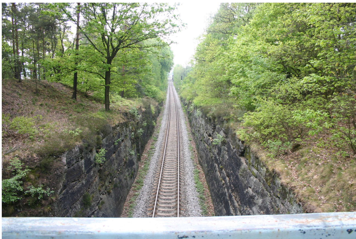
Obr.11. Trať zasekána do skály směr Doksy. Foto z mostu.
