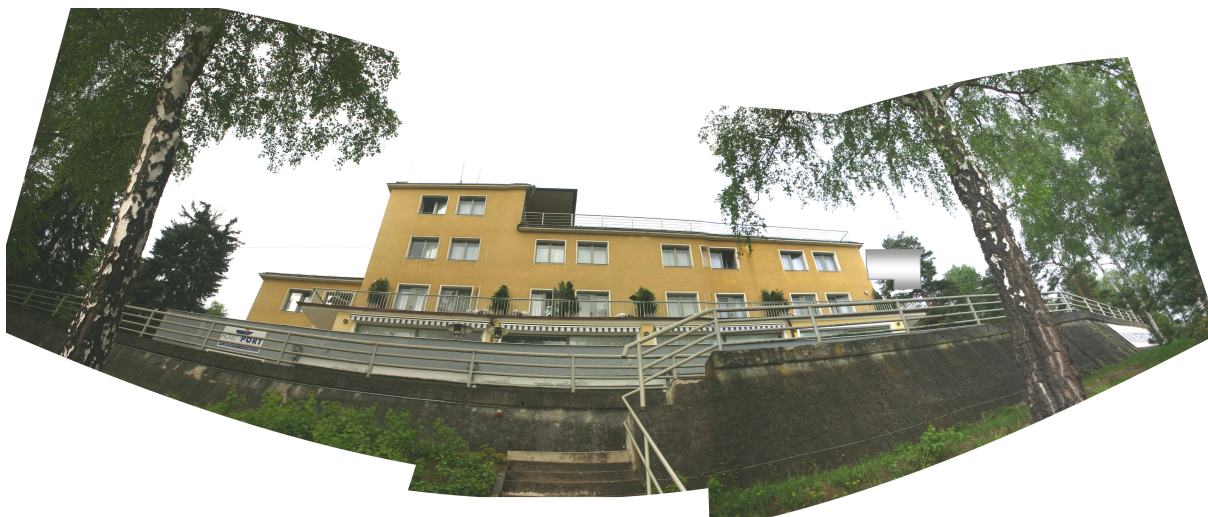
Obr.15. Pohled na hotel z pláže
