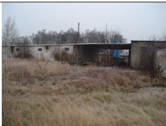
Pohled směrem ke stavebním firmám
