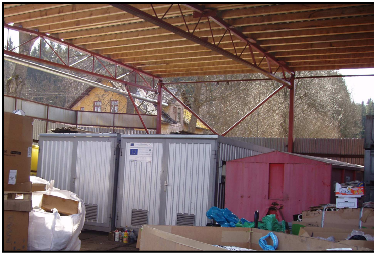
Obrázek č. 2: Kontejnery na nebezpečný odpad kontejnery na sorbenty
