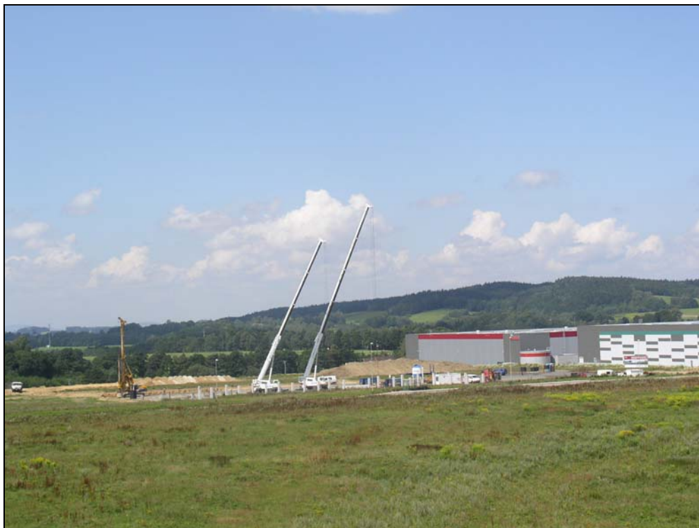
obrázek 2: Pohled od J na staveniště haly 5 VGP II, vpravo haly VGP I
